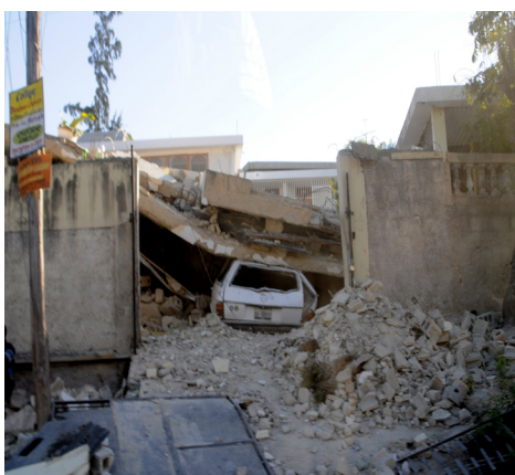
Vom Erdbeben zerstörte Gebäude
