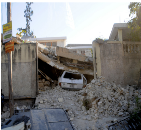
Vom Erdbeben zerstörte Gebäude
